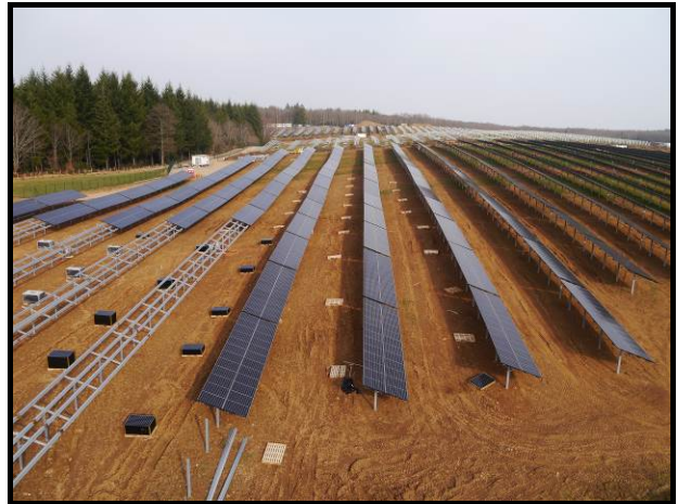
Pose des panneaux photovoltaïques © Photovidéodrone/La Compagnie du Vent
