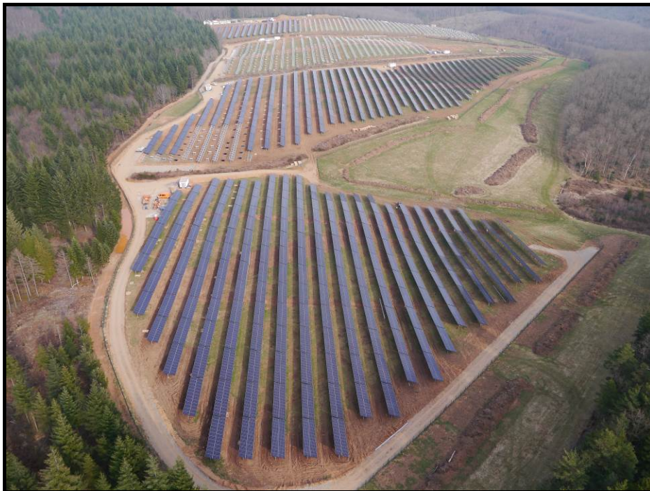
Centrale solaire photovoltaïque de La Forêt © Photovidéodrone/La Compagnie du Vent
