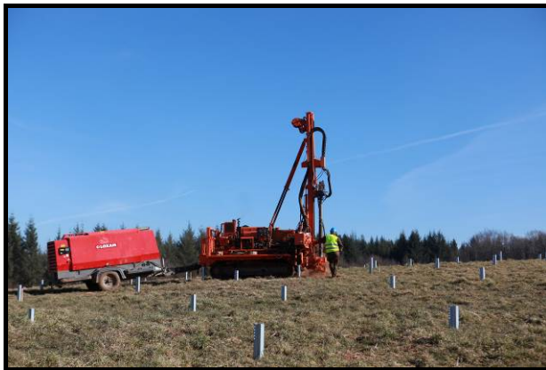
Battage des pieux accueillant les structures en acier © La Compagnie du Vent
