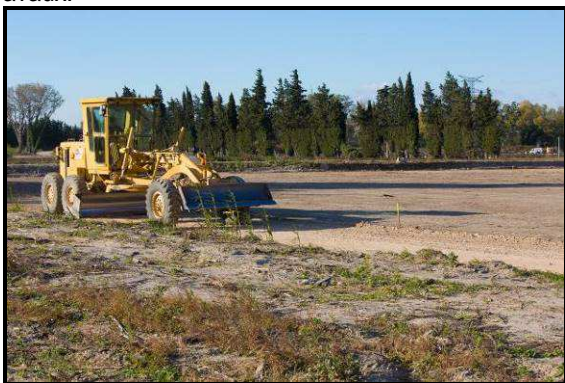
Terrassement d'un site de La Compagnie du Vent (Les Iscles – Bouches- du- Rhône)
