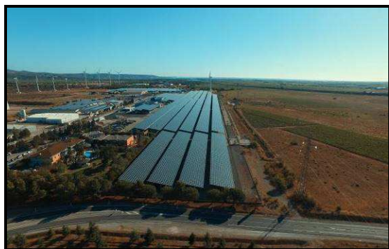
Vue aérienne des ombrières solaires photovoltaïques Walon Rivesaltes - © Drones Explorers 66
