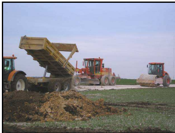
Création d'une piste d'accès sur un parc éolien de La Compagnie du Vent
