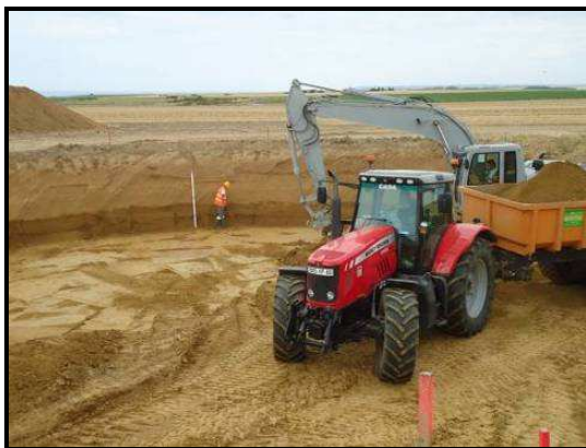
Fouille d'une fondation d'un parc de La Compagnie du Vent
