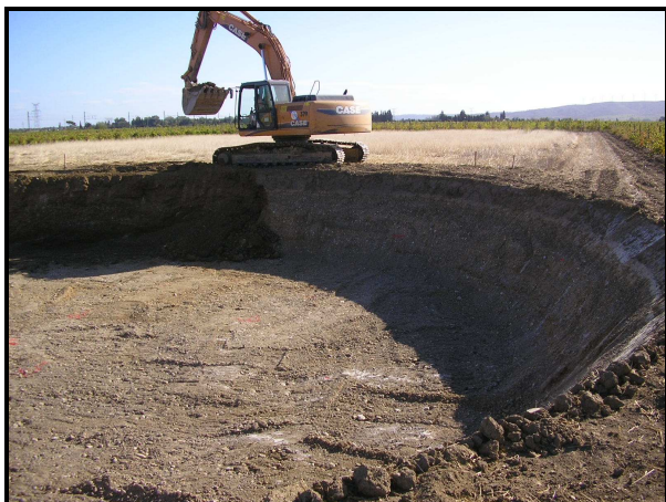
Fouille d'une fondation d'un parc de La Compagnie du Vent
