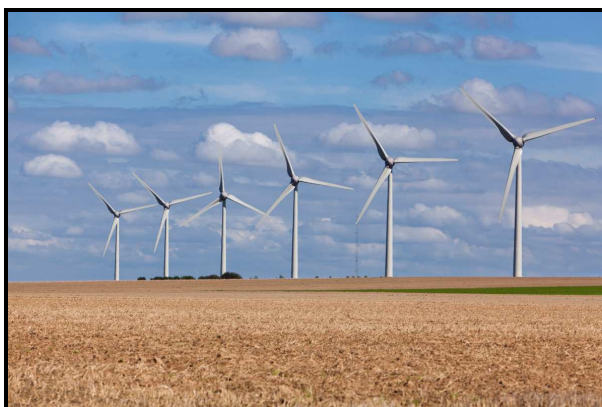
Parc éolien de Manneville (Seine-Maritime)
