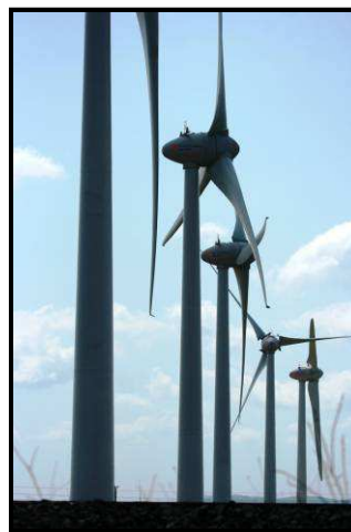
Parc éolien de Cruscades
