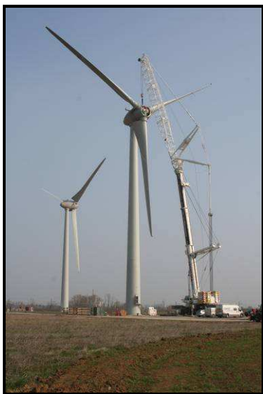
Chantier de Cruscades : montage d'une éolienne
