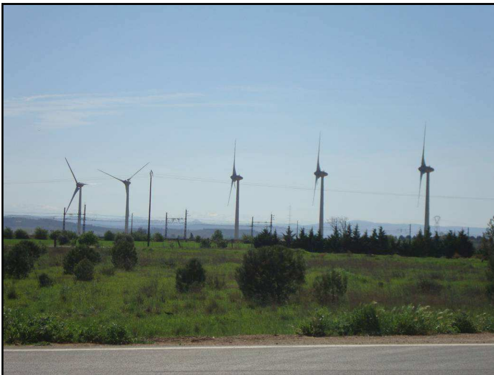
Parc éolien de Cruscades
