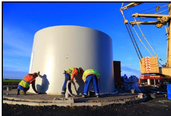
Mise en place de la première section de tour d'une éolienne du parc de Chemin du Bois Hubert ©David Blondin
