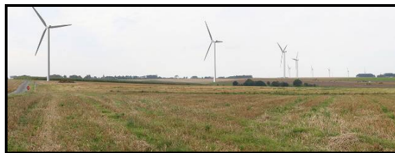
Simulation visuelle des parcs éoliens des Ramonts et de La Plaine de Bois de Falfosse
