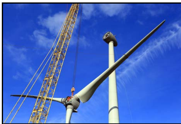
Levage du rotor d'une éolienne du parc de Chemin du Bois Hubert ©David Blondin
