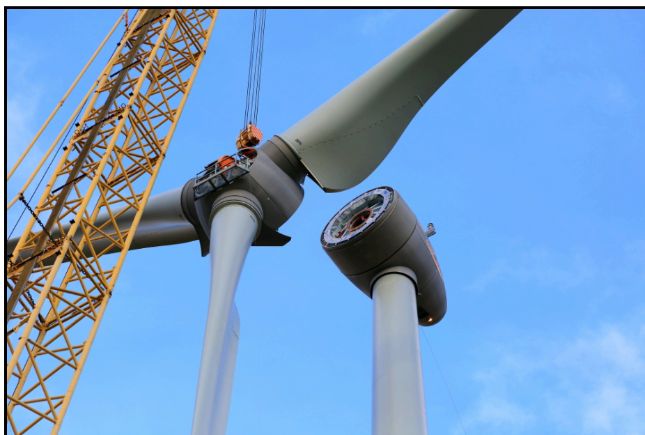
Montage éolienne parc éolien de Chemin du Bois Hubert ©David Blondin
