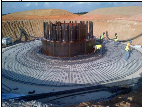
Ferraillage d'une fondation du parc éolien
