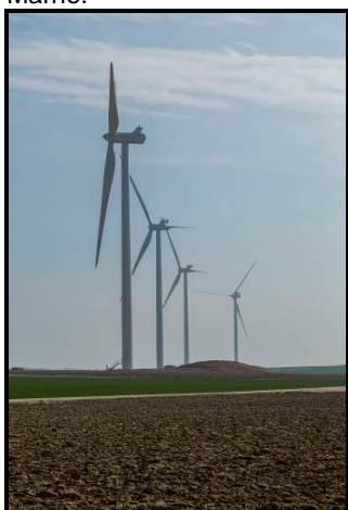
Parc éolien des Châtaigniers - © IMAGINESinAIR
