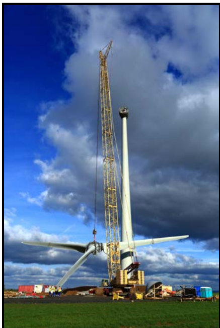
Chantier de Chemin du Bois Hubert : montage d'une éolienne ©David Blondin
