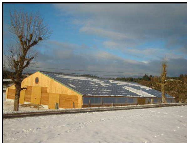
Centrale solaire photovoltaïque du Gévaudan (Lozère)
