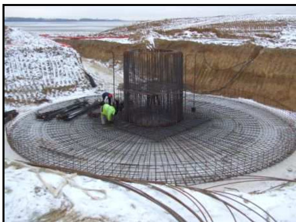
Ferrailage d'une fondation d'une éolienne du parc de La Picoterie
