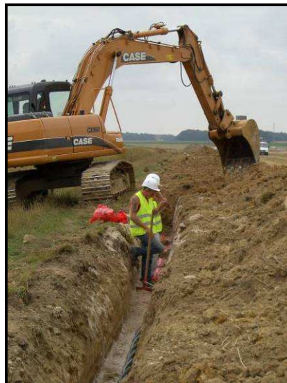
Réalisation des tranchées électriques sur le parc éolien de La Picoterie
