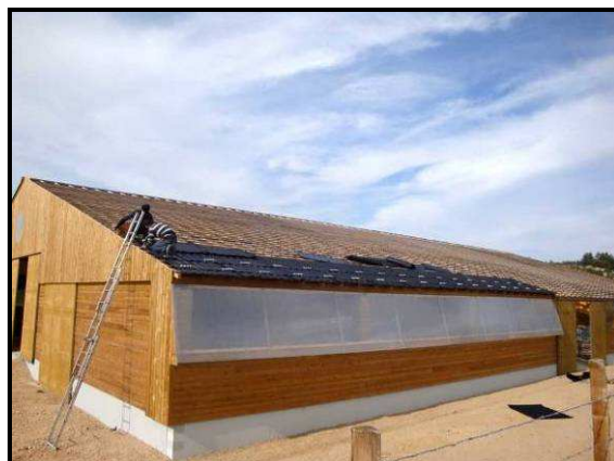
Construction de la centrale solaire photovoltaïque du Gévaudan (Lozère)
