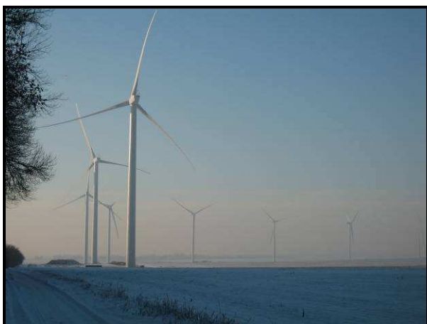
Parc en construction du Chemin des Haguenets (Oise) © J.Coulon
