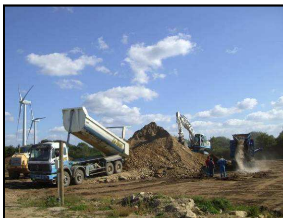
Engins remettant en état le site d'un parc de La Compagnie du Vent
