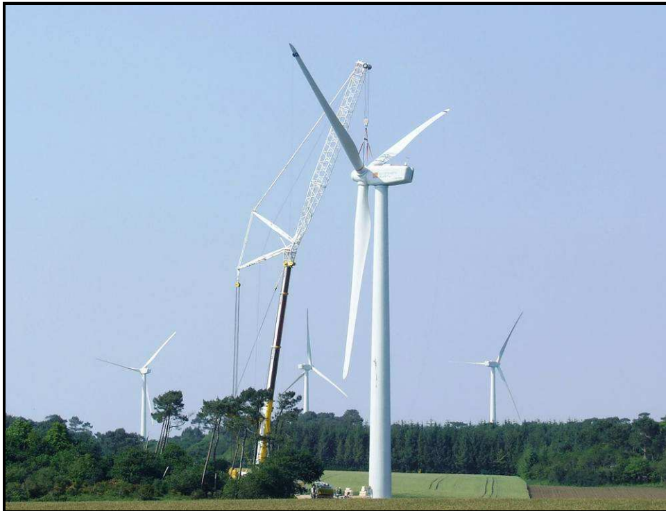
Montage d'une éolienne d'un parc de La Compagnie du Vent - © Pierrot Bosser
