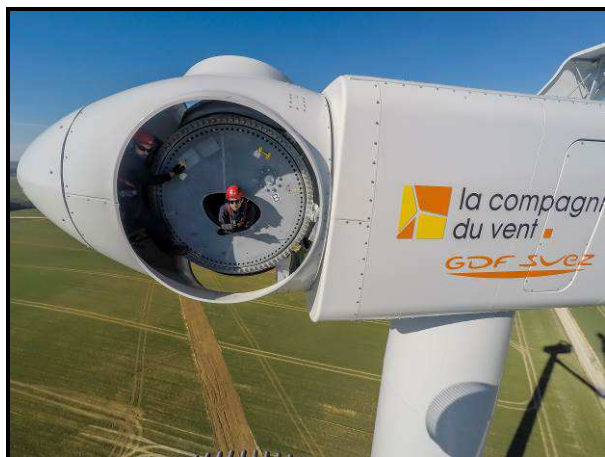
Chantier des Châtaigniers : montage du rotor ©La Compagnie du Vent/ImagesInAir
