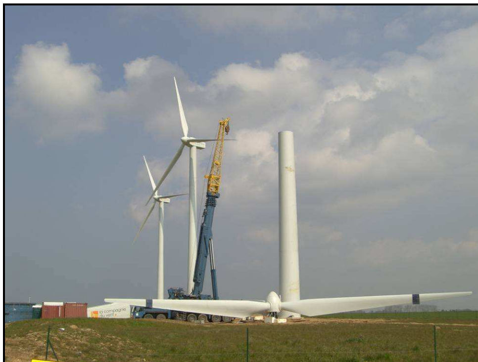
Montage d'une éolienne de La Compagnie du Vent
