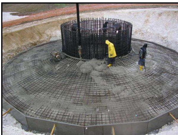
Coulage du béton d'une fondation d'une éolienne du parc du Miroir
