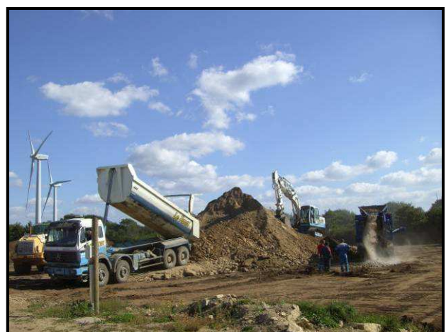
Engins remettant en état le site d'un parc de La Compagnie du Vent
