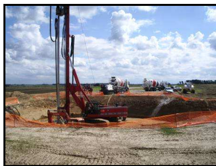
Renforcement de sol sous la fondation d'un parc de La Compagnie du Vent
