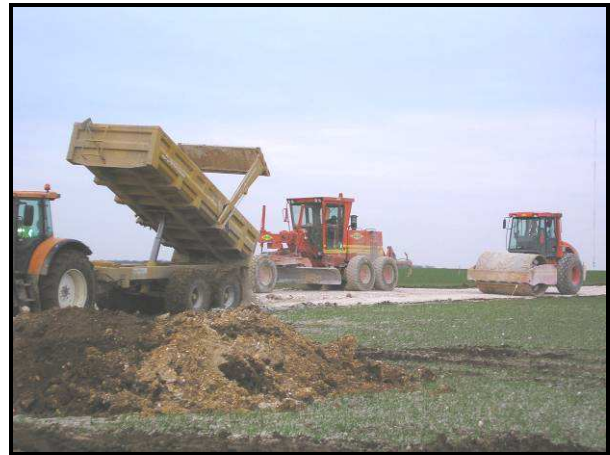
Création d'une piste d'accès
