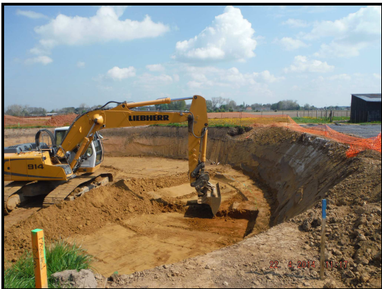
Fouille d'une fondation à Petit Terroir
