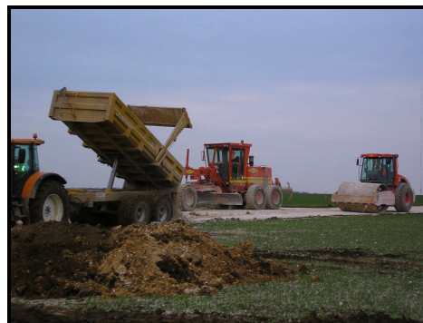
Création d'une piste d'accès sur un parc éolien de La Compagnie du Vent
