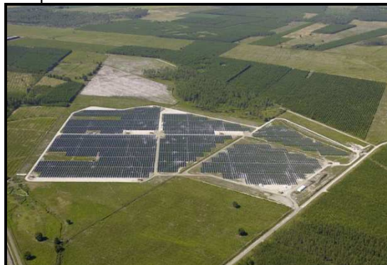
Vue aérienne de la centrale solaire de Langelé © Air Infrarouge
