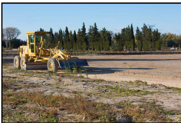
Terrassement d'un site de La Compagnie du Vent (Porette de Néronne – Corse)
