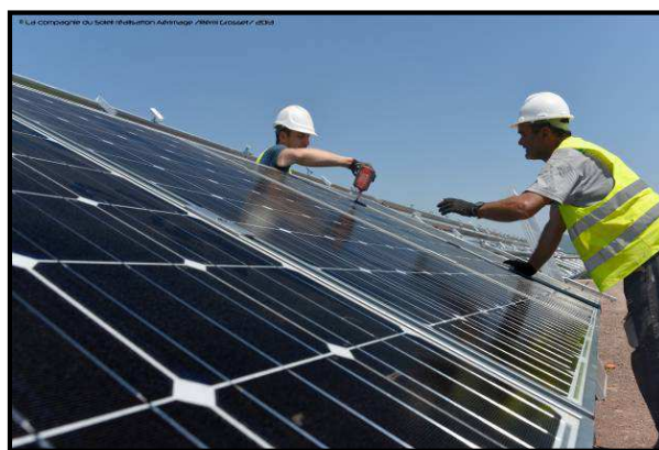
Montage de panneaux photovoltaïques (centrale photovoltaïque au sol des Iscles – Bouches-du-Rhône)
