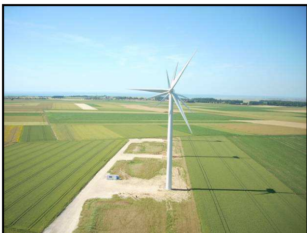
Vue partielle du parc éolien du Petit Terroir (Somme)
