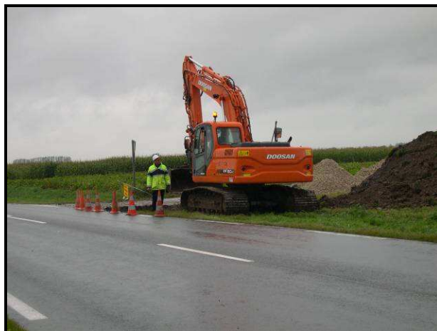
Création d'une piste d'accès sur un parc de La Compagnie du Vent
