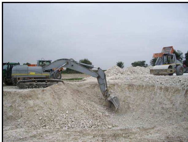
Fouille d'une fondation du parc éolien du Miroir (Somme-80)
