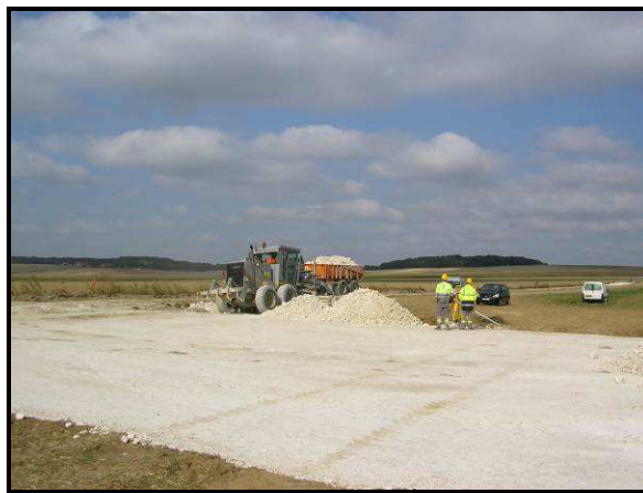
Création d'une piste d'accès sur le parc éolien du Miroir (Somme-80)
