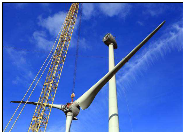
Montage d'une éolienne sur un parc de la Compagnie du Vent
