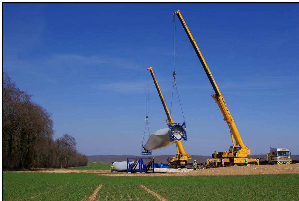
Transport de pales sur le parc éolien de la Bretelle et Echalot (21) ©La Compagnie du Vent/J. Bourrely
