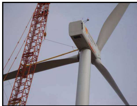
Chantier du Miroir : montage de la nacelle d'une éolienne
