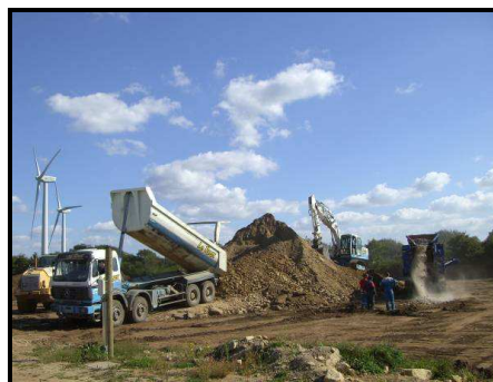
Engins remettant en état un parc de La Compagnie du Vent
