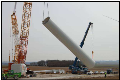
Chantier du Miroir : montage du mât d'une éolienne
