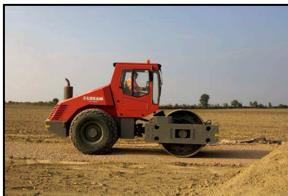
Engin remettant en état un parc éolien de La Compagnie du Vent
