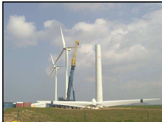
Chantier du Petit Terroir : montage d'une éolienne
