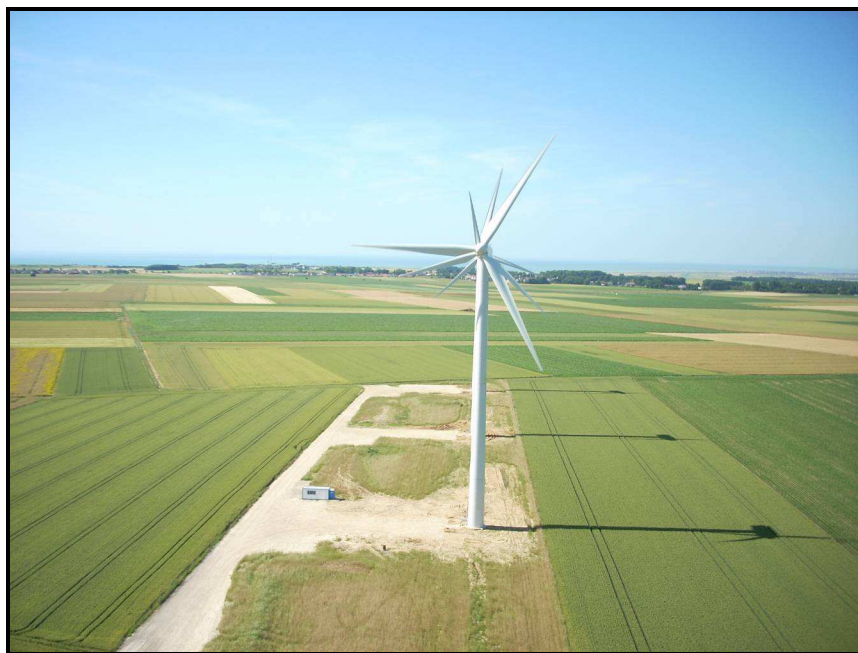
Vue aérienne et partielle du parc éolien du Petit Terroir
