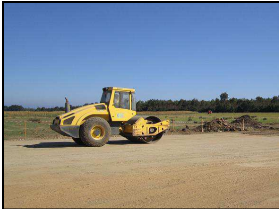
Terrassement d'un site de La Compagnie du Vent (Porette de Néronne – Corse)
