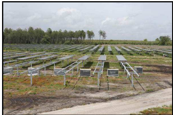
Montage des panneaux photovoltaïques sur un site de La Compagnie du Vent (Langelé – Landes)
