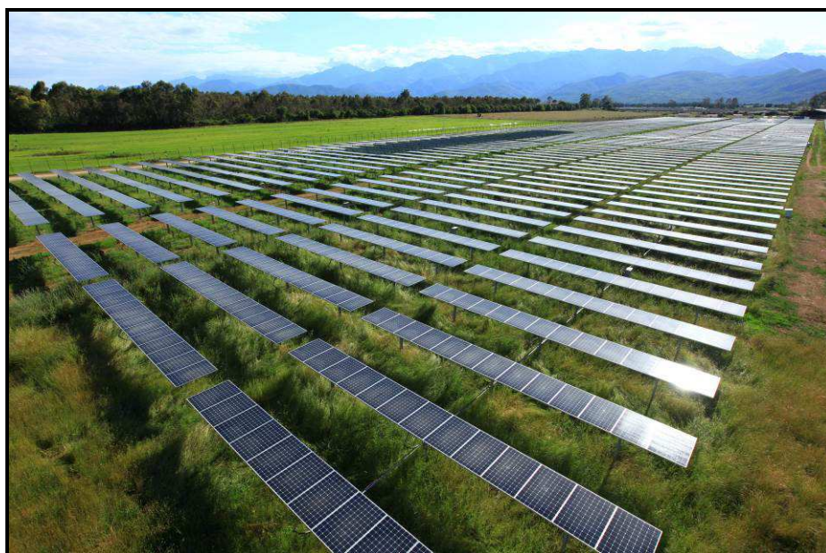
Exemple de centrale solaire photovoltaïque de La Compagnie du Vent (Porette de Néron – Corse) © GDF SUEZ - Camille Moirenc
