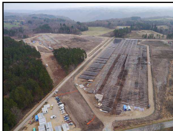
Centrale solaire de Roc du Doun en cours de construction © Photovidéodrone/La Compagnie du Vent
