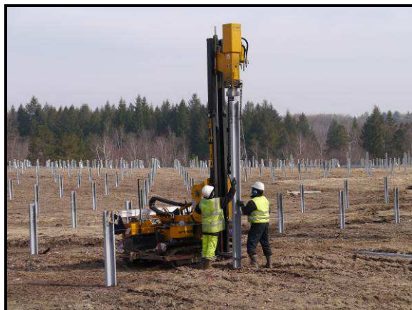
Battage des pieux accueillant les structures en acier © Photovidéodrone/La Compagnie du Vent
