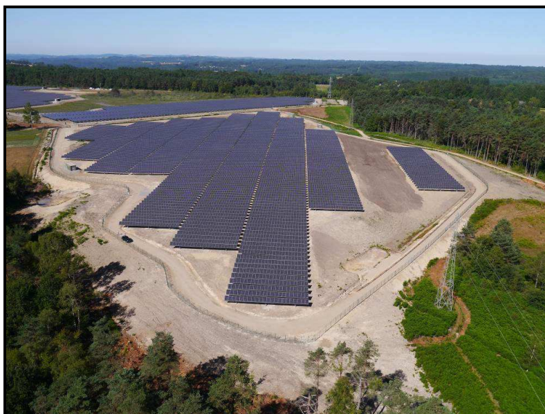
Vue partielle de la Centrale solaire photovoltaïque de Roc du Douin © Photovidéodrone / La Compagnie du Vent
