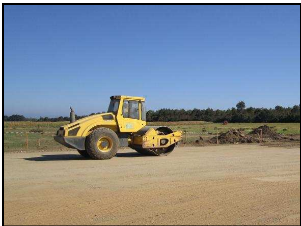
Terrassement du site par Corse Travaux
