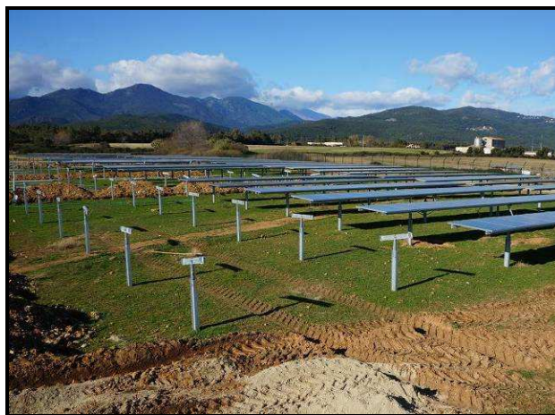
Montage des trackers et pose des panneaux photovoltaïques
