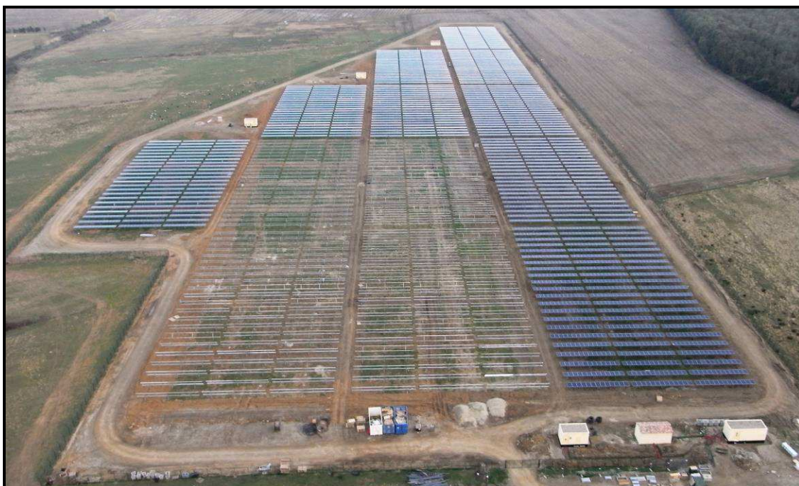
Vue aérienne du chantier de la centrale solaire photovoltaïque de Porette de Néron © Exosun
