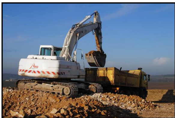
Fouille d'une fondation - parc éolien du Bretelle et Echalot (Côte d'Or-21) - 09/2011©Julien Bourrelly
