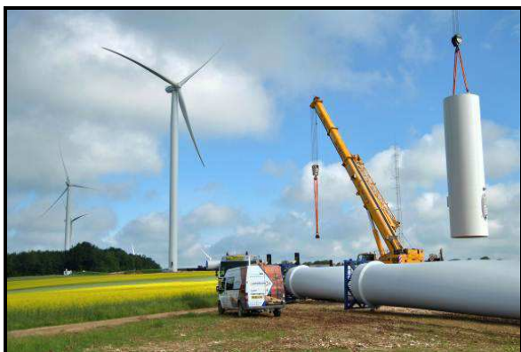
Chantier d'Echalot : montage d'une éolienne © Julien Bourrelly
