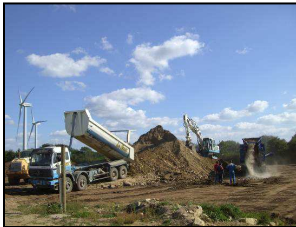
Engins remettant en état un site de La Compagnie du Vent
