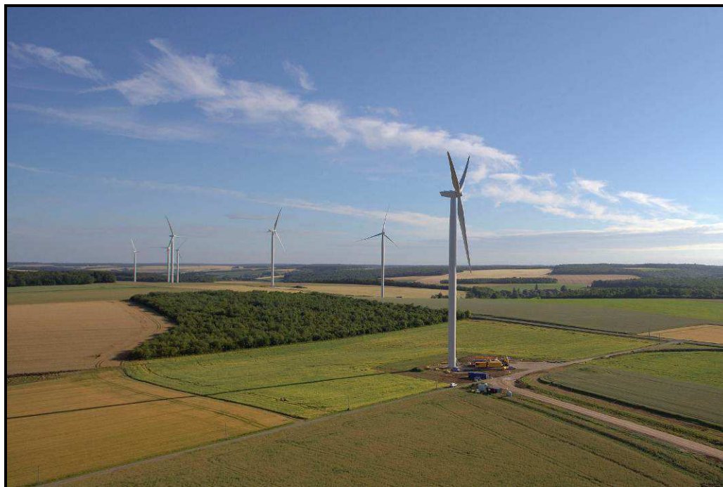
Vue aérienne et partielle du parc éolien de La Bretelle © Julien Bourrelly
