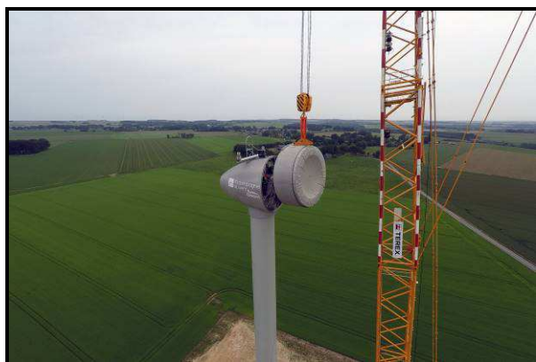
Montage d'une éolienne - Parc de Falfosse & Ramonts ©MyDroneService
