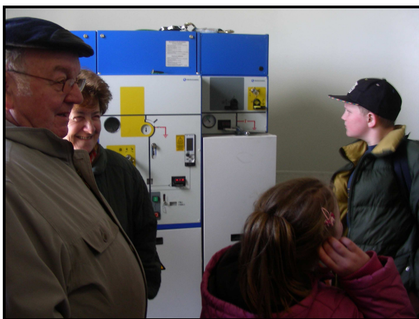
Visite de l'intérieur d'une éolienne de La Compagnie du Vent
