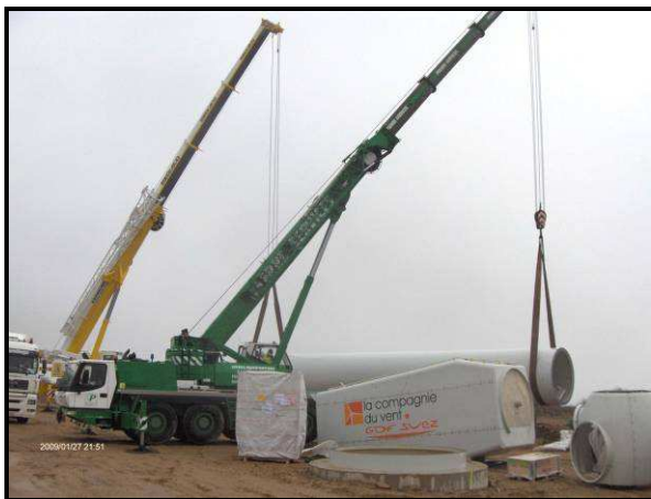
Déchargement des éoliennes du parc de Lanrivoaré
