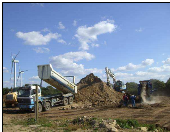
Engins remettant en état le site d'un parc éolien de La Compagnie du Vent
