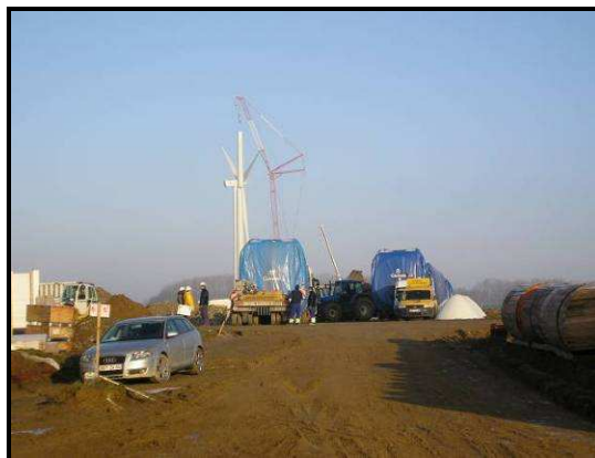
Parc de La Picoterie (Aisne) en construction
