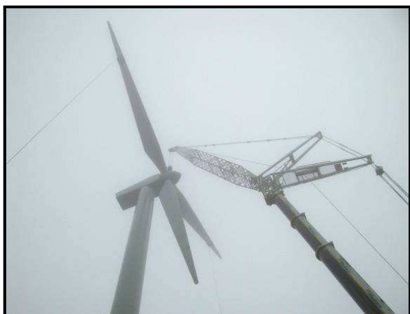
Montage d'une éolienne sur le parc de Lanrivoaré
