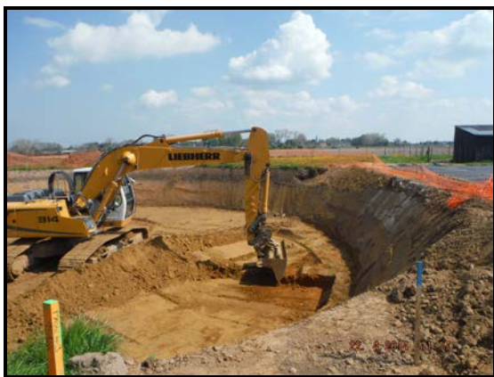
Fouille d'une fondation à Petit Terroir ©D. Carpentier
