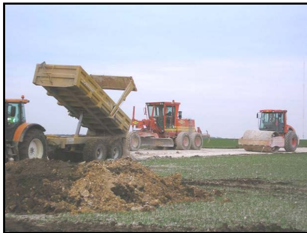
Création d'une piste d'accès
