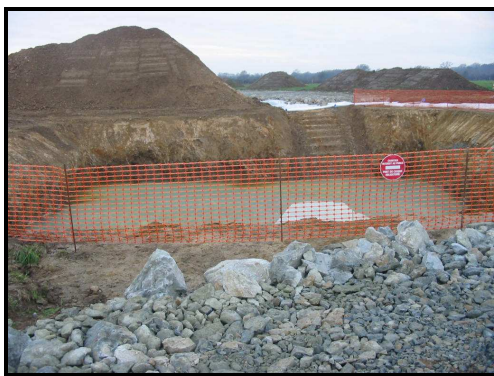
Fouille d'une fondation d'un parc éolien de La Compagnie du Vent
