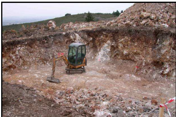
Fouille d'une fondation d'un parc de La Compagnie du Vent
