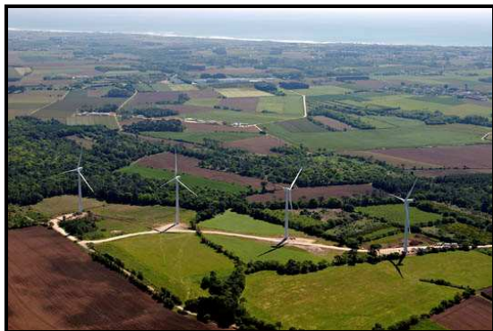
Vue partielle du parc éolien de Kérigaret (Finistère) - © La Compagnie du Vent - David Glevarec
