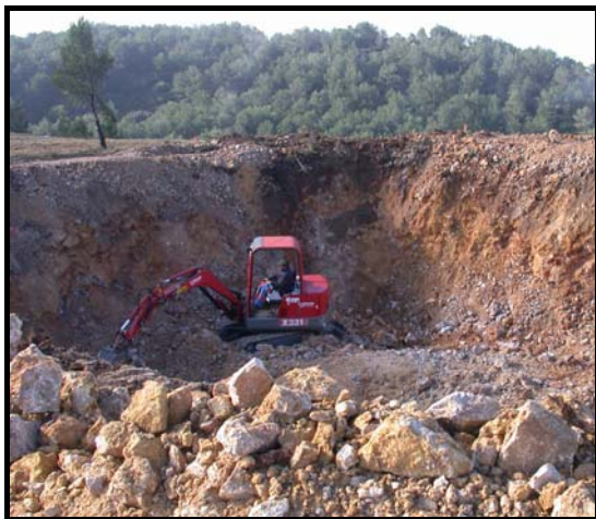
Fouille de la fondation de l'éolienne n° 21
