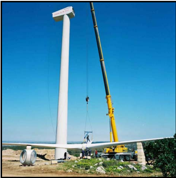
Montage du rotor de l'éolienne 19 (la plus proche du parc initial)
