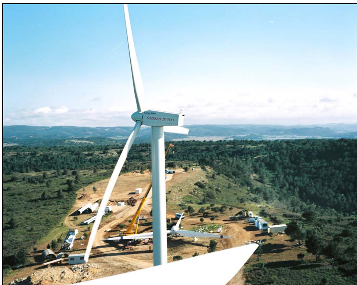
Montage des dernières éoliennes du parc de Néviau, en avril 2004
